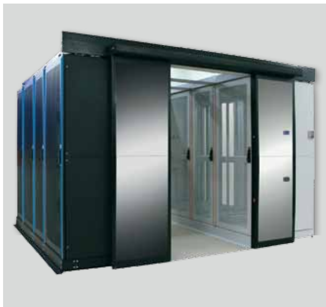
Система «горячий» коридор
